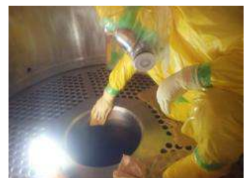
開放点検時系統内除染作業(3)
