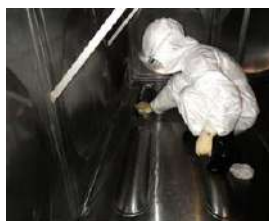
排水設備内の清掃
