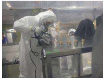
グローブボックス解体撤去作業
