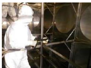
排水設備内の清掃
