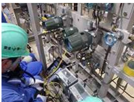
プロセス計器定期点検校正
