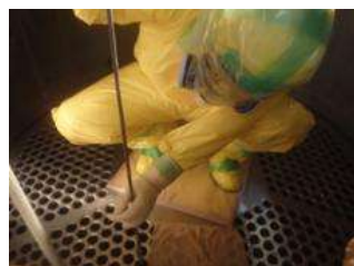
開放点検時系統内除染作業(2)
