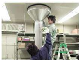
RI施設設備点検(風量測定)
