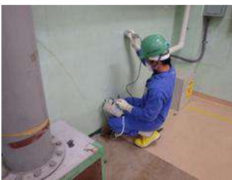
汚染調査作業(1)
