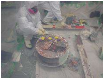
汚染装置解体撤去作業
