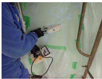
汚染調査作業(2)
