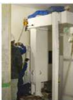
遮蔽体の設計・製作・設置
