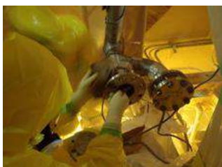
開放点検時系統内除染作業(1)
